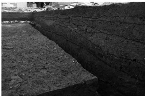
南壁断面 (西より)
