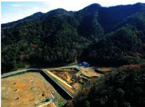
(2) 調査地遠景 (北西から)
