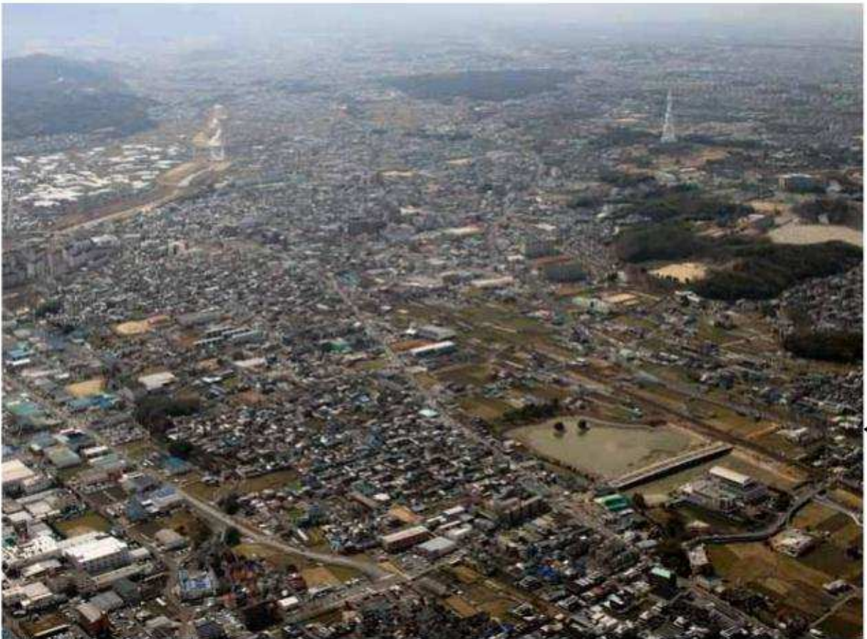
北上空から見た調査地 ▲
