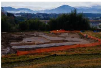
2区 全景 (南東より)
