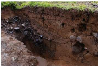
2区6 T北東端断面 (西より)
