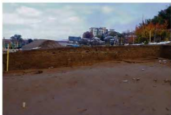
2区10 T断面 (南西より)
