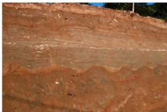
2 T断面 (南西より)
