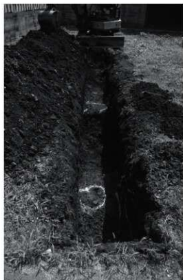
図61 調査区全景(南西から)
