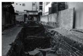
図10 埋め戻し風景 (南から)
