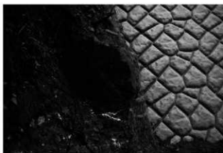
図78 No.1石垣検出状況(南から)
