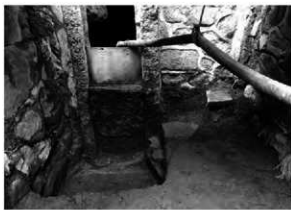
図21 樋門調査区(東から)
