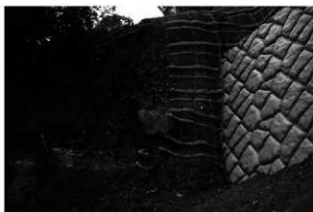
図77 No.1石垣検出状況(東から)
