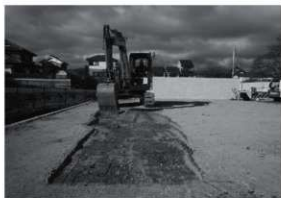
図3 機械掘削作業状況(東から)
