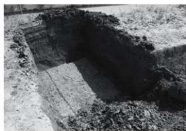
図4 拡張部掘削状況（北東から）
