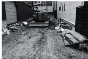
図3 重機掘削状況(北から)
