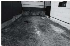
図5 埋め戻し状況(北から)
