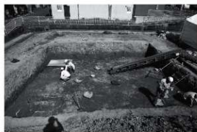
図2 調査風景（西から）
