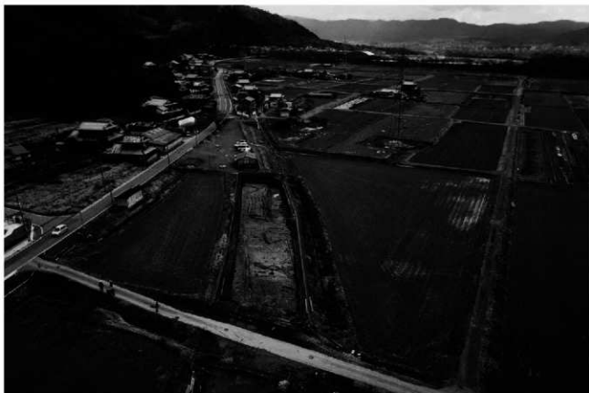
(1) 2区全景(北から)
