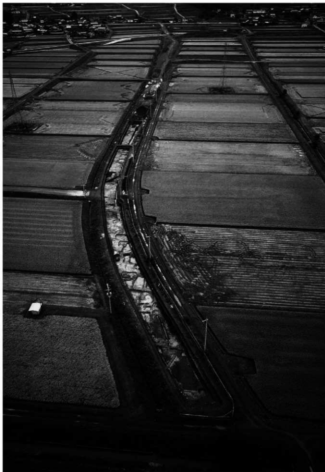
1～3区全景(空中写真、西から)
