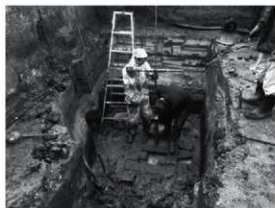
第2図 シンウォールサンプラーによるボーリング
