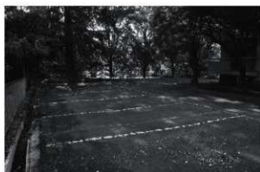
图3 3区調査前全景 (西から)
