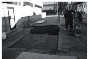
図6 道路舗装状況(西から)
