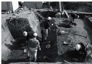
図3 人力掘削作業状況(南東から)
