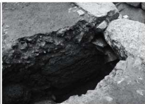
3 犬走り断割状況（北東から）
