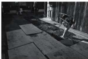
図5 埋め戻し状況(北東から)
