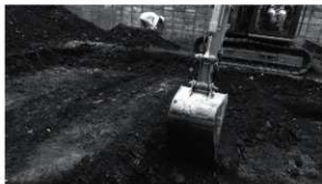
図2 重機掘削風景(東から)
