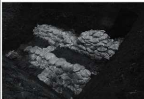
4 1区埋戻し状況（北西から）
