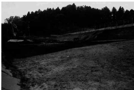
(2) B 2 トレンチ中央南北畦土層 断面(西から)
