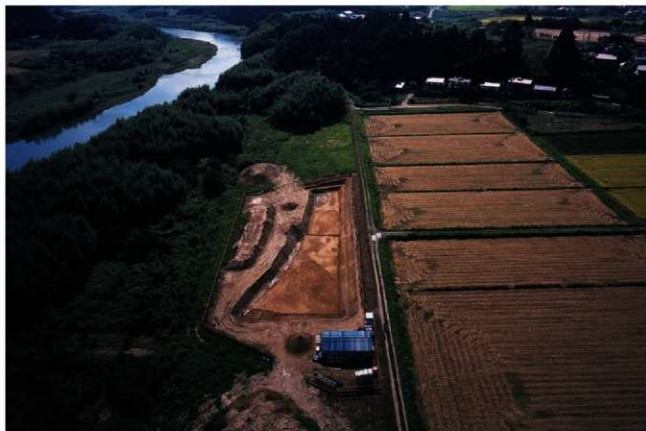
(1) Aトレンチ全景(北東から)
