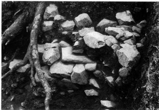
Fトレンチ石垣検出状況
