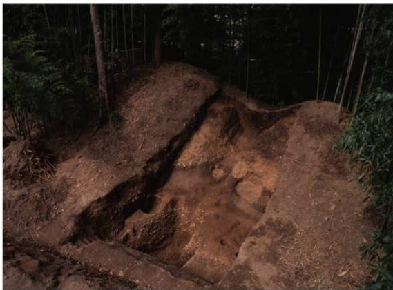
(1) 東西土塁を開削する溝と土塁の南側で終息する堀（南東から）
