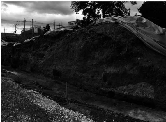
(2) 整備工事中の土墨崖面 (南東から)
