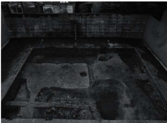
1 第6調査区全景（北から）
