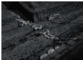
図4 遺構養生状況（南西から）
