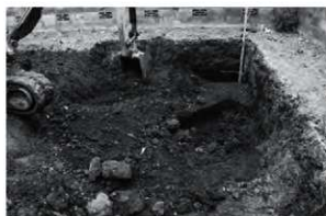
図3 人力掘削作業状況（北から）
