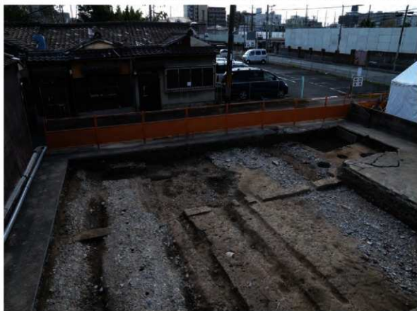
1 第5調査区全景（北東から）
