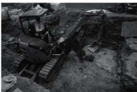
図5 埋戻し風景（北東から）
