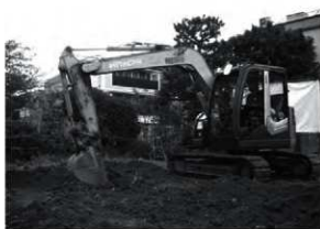
図2 重機掘削（北西から）
