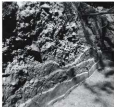
図81 B地点3区北壁断面近接(南西から)
