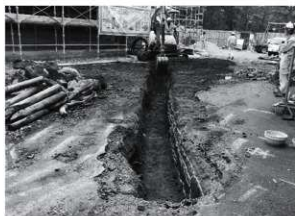
図2 試掘調査 重機掘削作業状況
