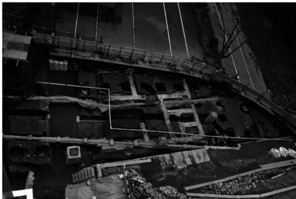
1. 複乱除去状況全景 2015年3月23日撮影(下が北)
