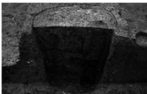
8. 3号建物柱17断面(南から)
