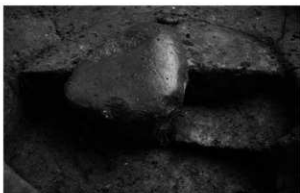
4. 3号建物柱7断面(東から)
