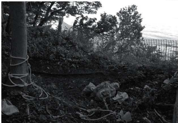
5号整穴 (TR5-Pit3) 掘削前状況
