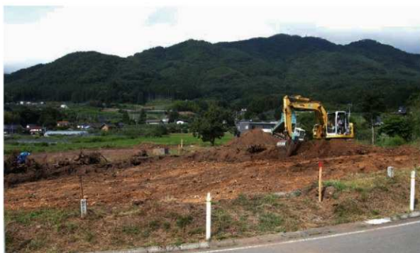
写真4 3区表土掘削状況
