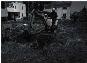
8区 重機作業状況
