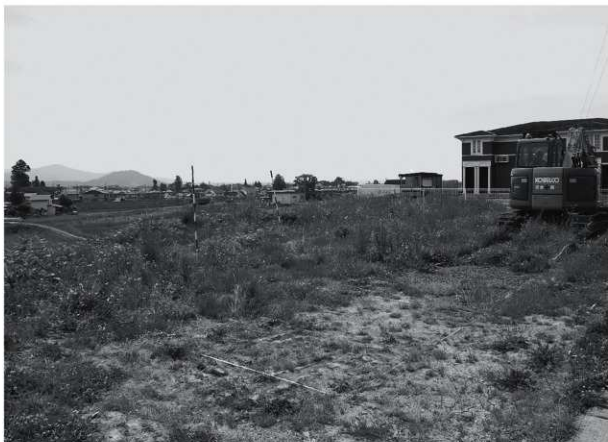
調査前状況（北から）
