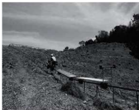
資材運搬用モノレール
