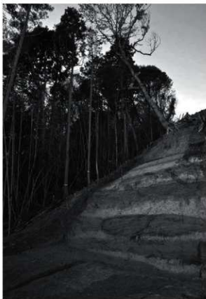
曲輪 2 東側の切岸（北東から）
