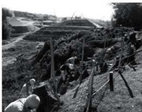
急傾斜面での作業風景
