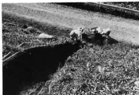
西側急斜面作業風景
