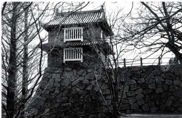
現状の祈念槽（福岡城内）
