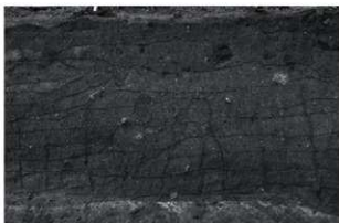
4 6区丘陵裾部南部南壁断面（4）（北から）
