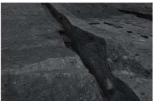
4 SD13・SS4・SS8 断面 (南東から)
