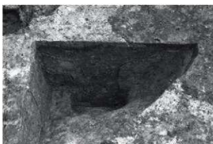
8 S11-P6 断面 (南から)
