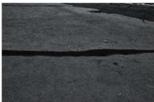
3 6区平地部南部畦畔1断面（北東から）
