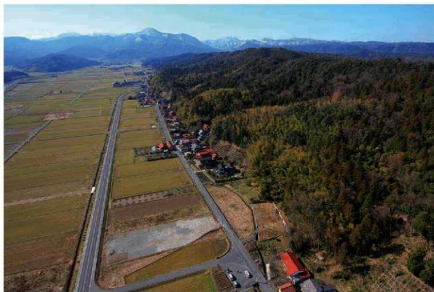
2 4～6区調査前遠景（北上空から）
