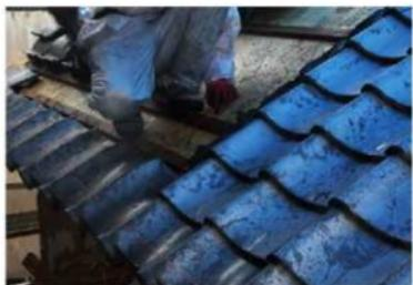
屋-3 瓦葺き施工状況
