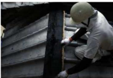
屋-8 渡り廊下瓦葺き施工状況
