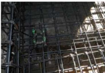
鉄-4 アンカーボルトセット完了
