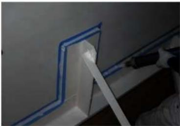
その他-4 鉄骨シーリング施工状況
