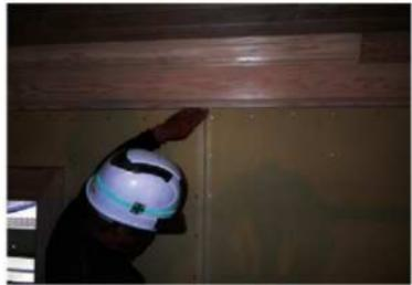
左-11 内壁上部 PB ジョイントボーダー施工
