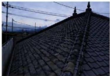
屋-13 瓦葺き施工完了
