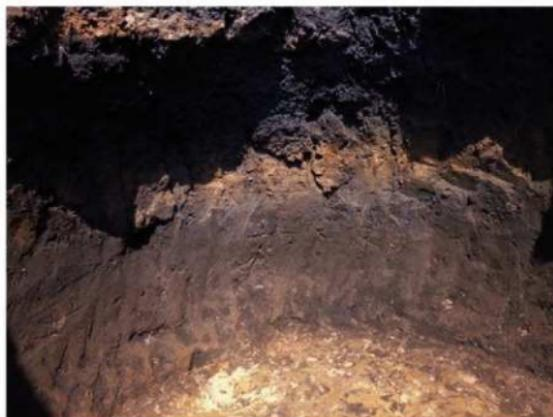
垂直に立つ壁のトップ付近にK-Ahが露出し、やや壁面の荒れた付近から天井側にクロボク、盛土がみえる。構造的に、壁面に比べ天井は弱い。
