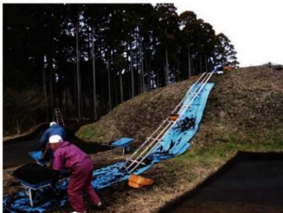
廃土処理の効率化を図るため、タケ組みを墳丘に立てかけ、乗せ土の重みを利用してテミを滑らせ、墳裾で手押し一輪車へ積み替え搬出した。ブルーシートはこぼれた土を受けるためのもの。
