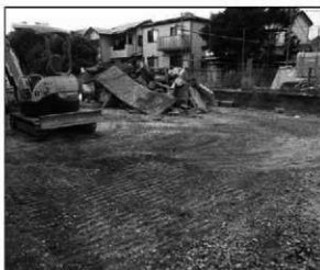
6. 埋め戻し (4トレンチ)
