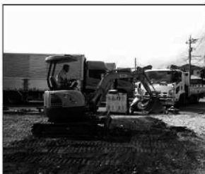
5. 埋め戻し (3トレンチ)
