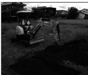
5. 埋め戻し (3トレンチ)
