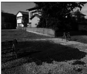
5. 埋め戻し後 (4トレンチ)
