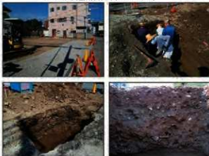
写真 調査状況
