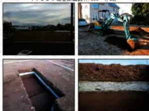
写真 調査状況
