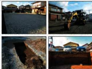
写真 調査状況
