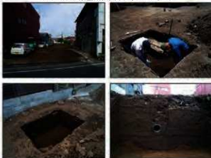
写真 調査状況
