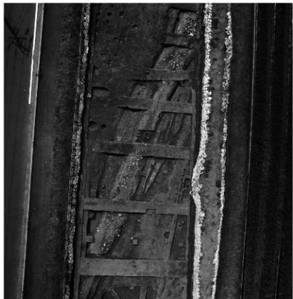
铺装道路全景
