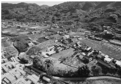
1. 調査地遠景1(北西上空から)
