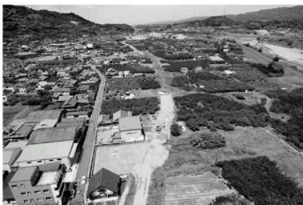
1. 1-1区・2区遠景(東上空から)
