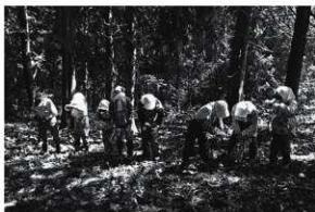
ボーリング調査作業の様子
