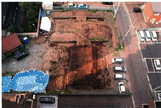
試掘調査トレンチと南半部調査状況
