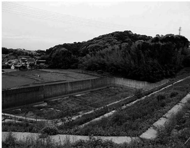
(1) 調査地調査前遠景 (調査から)
