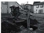
写真13 調査風景(NE→)
