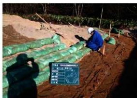
植生土のう積上げ状況 (W→)
