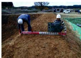
土壘盛土天端計測状況 (E→)
