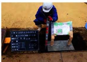
遺構説明板基礎コンクリート出来形測定状況 (W→)
