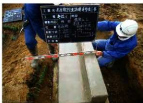
橋基礎コンクリート出来形測定状況 (N→)
