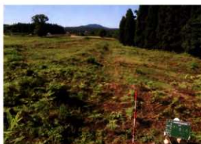
外郭盛土着工前 (S→)
