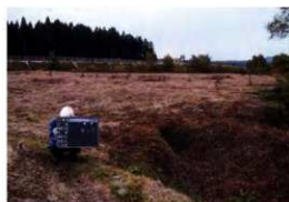
盛土着工前 (SE→)
