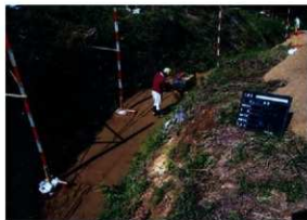
壕盛土転圧状況 (S→)
