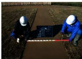
园路舗装出来高測定状況 (E→)
