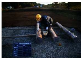
キシラデコール塗布状況【1回目】(N→)
