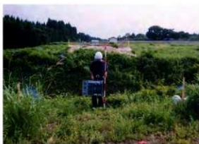
塚盛土着工前 (N→)
