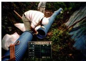
塚盛土暗渠管設置状況 (E→)
