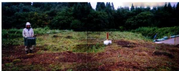
内郭盛土着工前 (W→)
