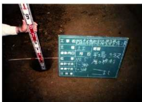
内郭盛土シラス厚さ測定状況 (S→)
