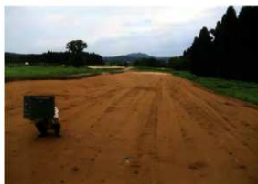
外郭盛土完成 (S→)
