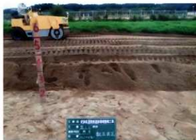
内郭盛土転圧状況 (E→)
