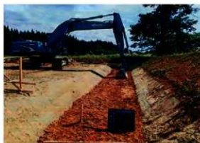
塚底部粘性土敷均し状況 (N→)
