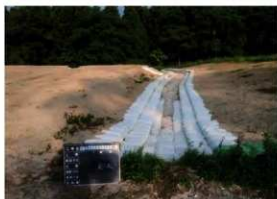
内郭土のう工完成 (W→)
