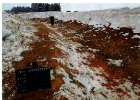
北壕植生土のう積工着工前 (N→)
