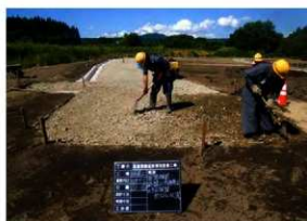
園路舗装路盤工砕石敷均し状況(S→)
