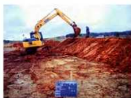
北土壘盛土状況 (N→)
