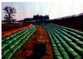
北壕植生土のう積工完成 (N→)
