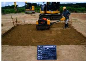
建物跡表示凍上抑制層転圧状況〔19H〕（E→）
