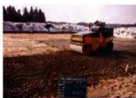
盛土完成 (S→)
