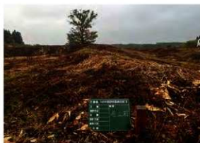
土壘盛土着工前 (E→)
