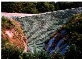
塚盛土完成 (W→)
