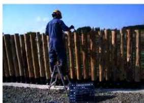
天端部ニス塗布状況(E→)
