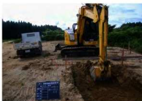
門・柵列復元工掘削状況 (N→)
