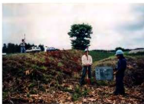
塚盛土・法面工着工前 (E→)
