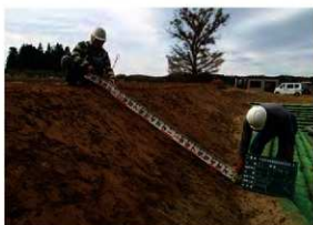
土壘盛土法面計測状況 (E→)
