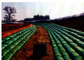
北壕植生土のう積み上げ状況 (S→)
