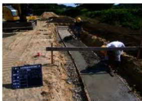
門・柵列復元工コンクリート打設状況 (N→)
