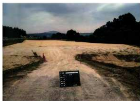
内郭盛土完成 (S→)
