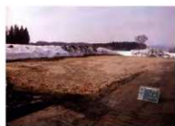
盛土着工前 (S→)
