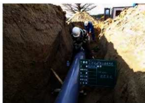
暗渠管設置状況 (E→)
