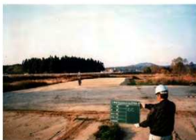
内郭盛土完成 (S→)
