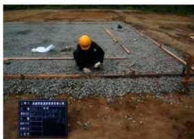
建物跡表示型枠組立状況〔23H〕（E→）
