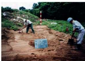
塚盛土・法面工砂敷均し状況 (S→)
