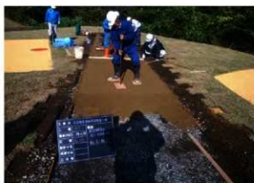
园路舗装作業状況 (S→)
