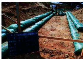
植生土のう積上げ状況 (E→)
