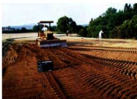
内郭盛土シラス敷均し状況 (S→)
