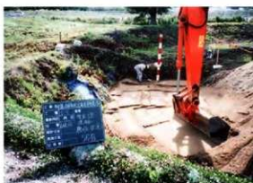
南西側塚盛土敷均し状況 (E→)
