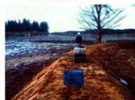
南土壘盛土転圧状況 (E→)
