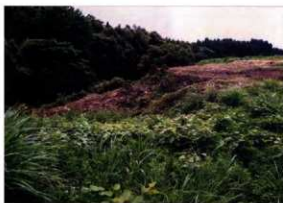
法面工着工前 (W→)
