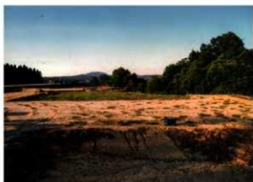
内郭盛土着工前 (S→)
