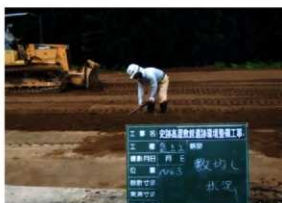
外郭盛土敷均し状況 (W→)
