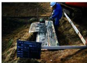
橋基礎コンクリート打設状況 (N→)
