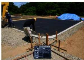
建物跡表示仮枠コンクリート撤去状況〔23H〕（SW→）
