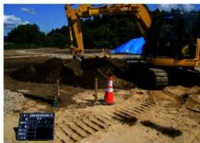
黒土敷均し状況 (SW→)
