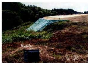
法面工完成 (W→)
