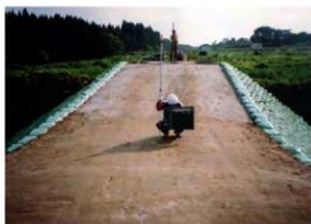
塚盛土完成 (N→)
