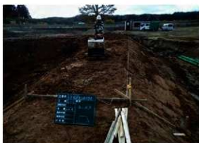
土壘盛土作業状況 (E→)
