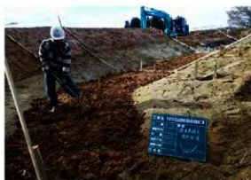
塚底部粘性土数均し状況 (E→)
