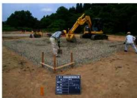
建物跡表示碎石敷均し状況〔23H〕（SW→）
