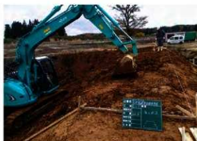
土壘盛土作業状況 (E→)
