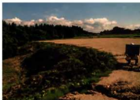
内郭植生土のう工・種子吹付着工前 (N→)
