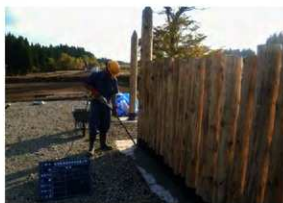
門・柵列復元工モルタル仕上げ状況(N→)
