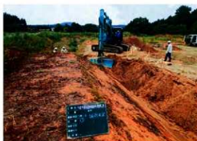
塚掘削状況 (S→)
