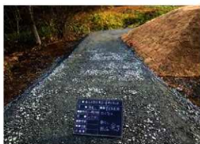
管理用通路完成 (N→)
