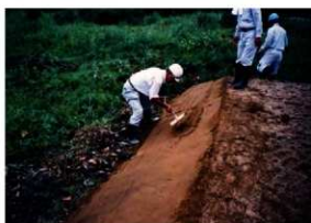
内郭盛土法面補正状況 (W→)
