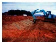
北壕掘削状況 (S→)
