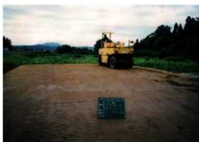
内郭盛土シラス転圧状況 (S→)
