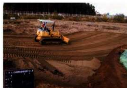
盛土砂敷均し状況 (SE→)
