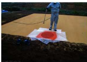
建物跡平面表示薄層カラー舗装作業状況（E→）
