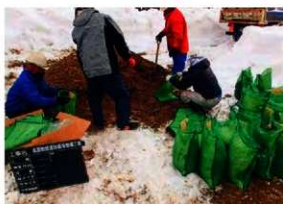
植生土のう作成状況
