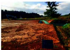
内郭盛土完成 (N→)
