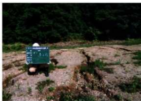
内郭土のう工着工前 (W→)
