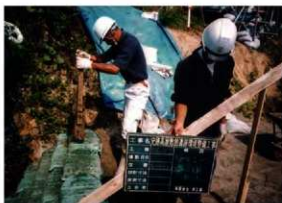
塚盛土植生土のう設置状況 (N→)
