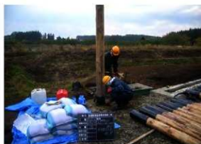
門復元工建込状況(E→)
