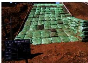
植生土の敷並べ完成 (E→)
