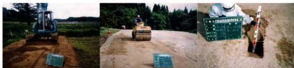
内郭盛土砂敷均し状況 (E→)
