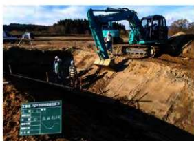
塚掘削状況 (SE→)
