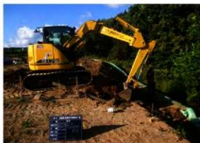
法面整形状況 (S→)
