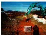
北壕底赤土敷均し状況 (S→)
