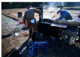
基部アスファルト塗布状況(W→)
