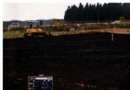
盛土黒土敷均し状況 (SE→)
