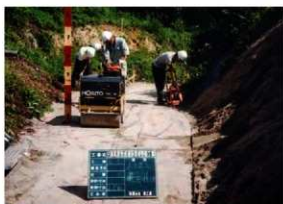
塚盛土砂転圧状況 (W→)
