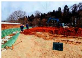
内郭盛土作業状況 (S→)
