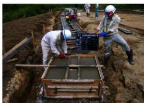
門・柵列復元工コンクリート仕上げ状況 (S→)
