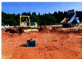
内郭盛土敷均し状況 (W→)
