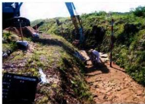
壕盛土敷均し状況 (N→)
