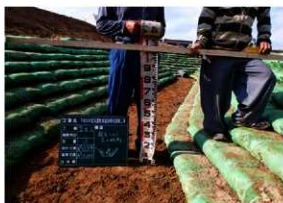
植生土のう積上げ高さ確認状況 (E→)
