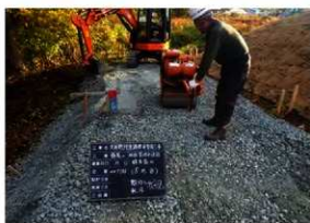
管理用通路碎石盛土敷均し・転圧状況 (N→)
