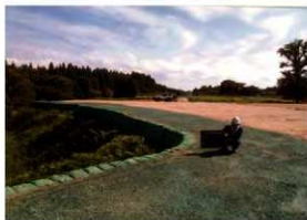
内郭植生土のう工・種子吹付完成 (N→)
