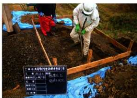
橋基礎掘削状況 (N→)
