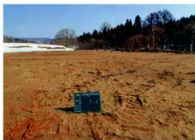
内郭盛土着工前 (S→)
