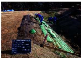
旧作業用仮設道路（塚）植生土のう設置状況（W→）
