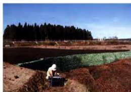
盛土完成 (SE→)
