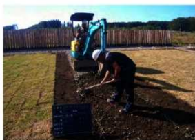
园路基面整正作業 (E→)
