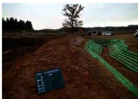
土壘盛土完成 (E→)
