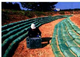
植生土のう積上げ完成 (E→)
