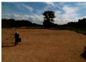
内郭盛土完成 (N→)
