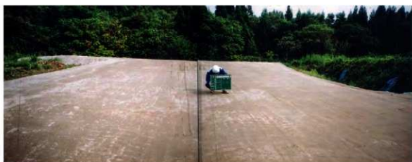
内郭盛土完成 (W→)
