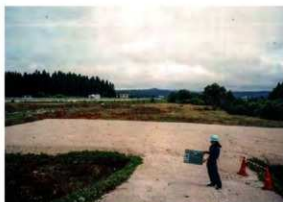
内郭盛土着工前 (S→)
