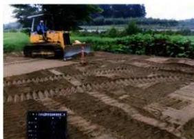
内郭盛土敷均し状況 (N→)
