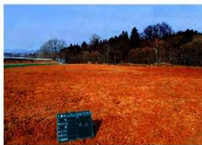
内郭盛土完成 (S→)
