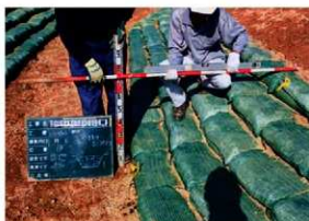
植生土のう高さ確認状況 (S→)
