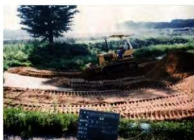
南西側塚盛土転圧状況 (E→)
