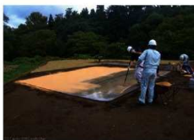
建物跡平面表示薄層カラー舗装作業状況（SE→）
