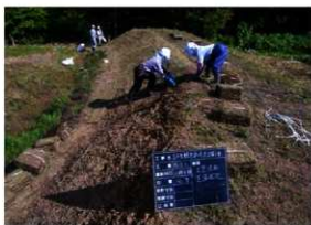
法面（土壘）芝張状況（W→）
