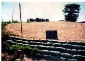
塚盛土・法面工完成 (E→)
