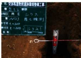
外郭盛土シラス厚さ測定状況 (S→)
