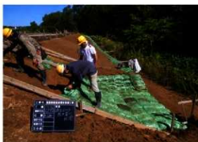
植生土の敷並べ作業状況 (S→)
