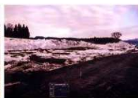
盛土転圧状況 (E→)
