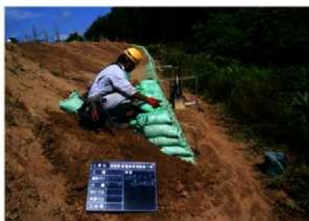
植生土のう積み状況 (S→)
