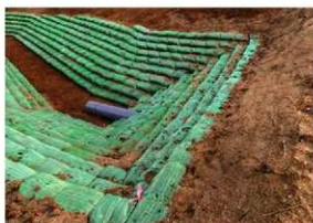
暗渠管設置完成 (NW→)
