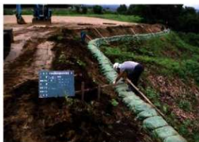
内郭植生土のう積み状況 (S→)
