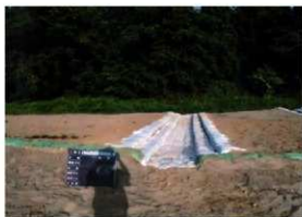
内郭土のう工完成 (W→)
