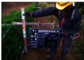
植生土のう積み高さ測定状況 (S→)
