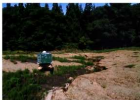
内郭土のう工着工前 (W→)
