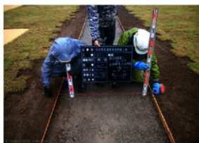
园路型枠設置寸法測定 (N→)
