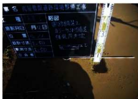
园路舗装厚さ確認状況 (S→)
