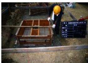
門復元工型枠組立状況 (S→)
