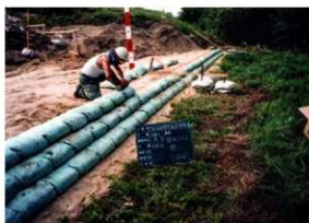
塚盛土・法面工植生土のう積上げ状況 (SE→)
