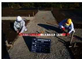
園路舗装路盤工出来高測定状況(W→)
