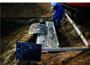
橋基礎コンクリート打設状況 (N→)
