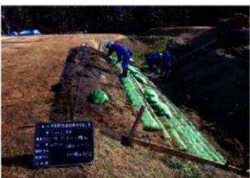
旧作業用仮設道路（塙）植生土のう設置状況（W→）
