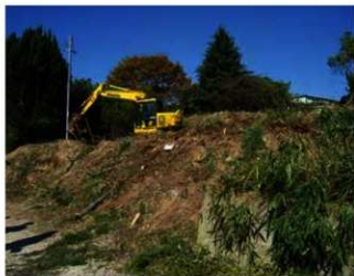
1 試掘調査 西区 調査前現況 (南東から)
