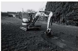
石井庵跡調査写真
