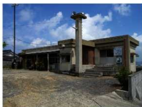
1 - 写真 02 兼久集落自治公民館
