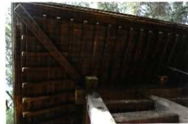
軒先、天井の状況
