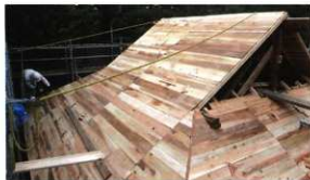
野地板の取り付け
