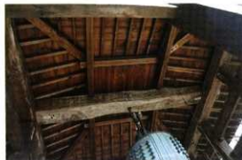
屋根架構の状況
