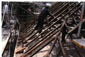
桁行側（垂木の状況） 妻側同様の形になっている
