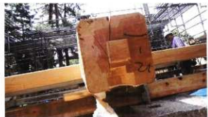
柱脚の加工状況
