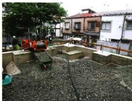
基礎コンクリート出来形
