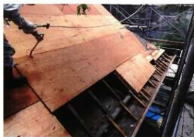
下地合板撤去状況
