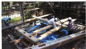
建て方（柱・貫の地組み）
