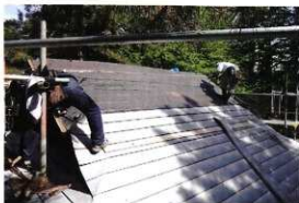
屋根トタン撤去状況 アスファルトフェルト張り
