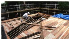
化粧野地板の施工
