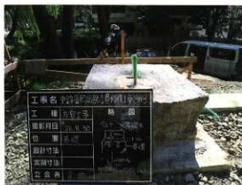
金物周囲及び基礎空隙部にグラウト材を注入して完了
