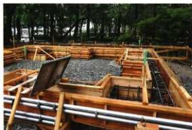
型枠設置状況
