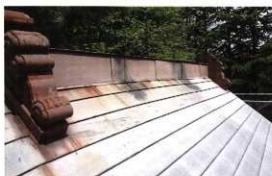
箱棟 カラートタンで葺かれている。
