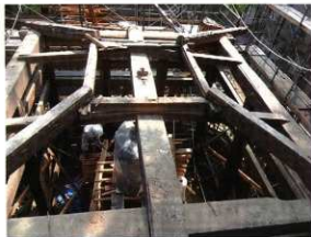
化粧垂木撤去後の状況 材の状況は大きな劣化が少ない。
