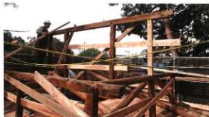
小屋組の状況（小屋貫は全て交換）
