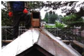
箱棟トタン撤去状況
