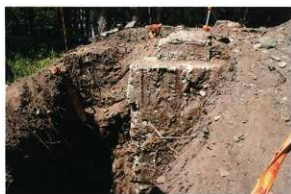
ラップコンクリート施工状況確認
