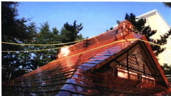
屋根銅板葺き完了
