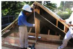
妻側の破風板取り付け
