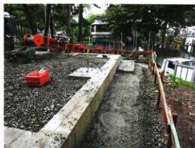
基礎内部埋戻し
