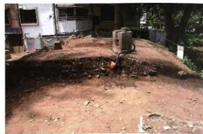
鐘樓基礎掘り下げ・土層確認（北東部）
