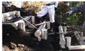
階段の設置(栗材を使用)
