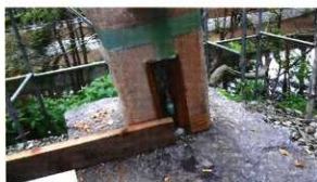
柱脚部 引寄せ金物の取り付け
