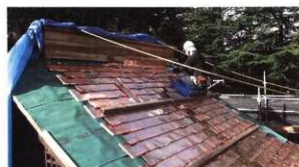
箱棟鋼板張り作業状況
