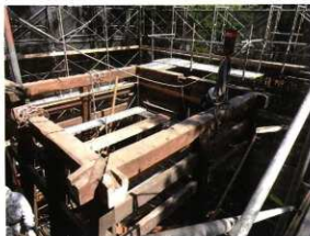
柱・貫撤去の状況
