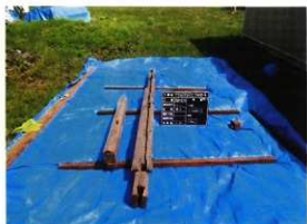
棟木 蟻継ぎとなっている
