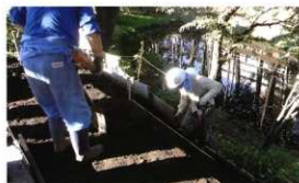
法面の整形状況
