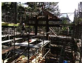
桁撤去作業
