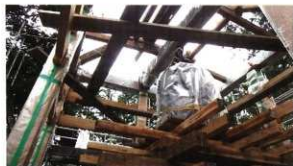
時鐘の吊り込み (下部に井桁状の木組)
