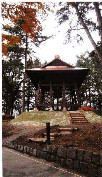
完成状況 南側外観
