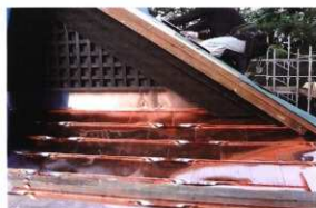
妻壁鋼板の納まり
