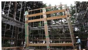
クレーンによる建て起こし
