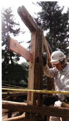
棟束（北側を交換） 写真右側の既存材は断面欠損 が大きかったため処分するこ ととした
