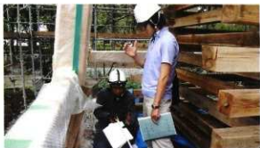
建て入れ検査 下げ振りにより目視確認
