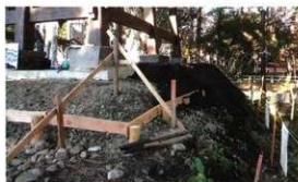
客土入れ(流れ止めとして土留めを設置)
