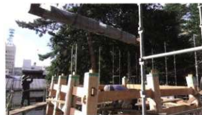
梁・桁の組み立て
