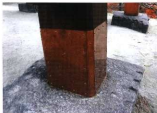
柱脚部分の銅板巻き
