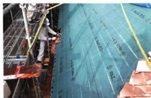
軒先部の鋼板張り作業
