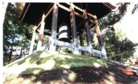
法面保護のため芝生張り
