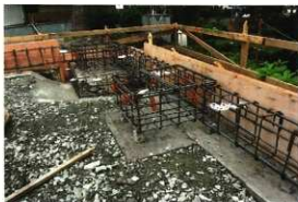
基礎配筋状況
