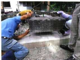
礎石の据え付け状況
