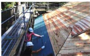
屋根（アスファルトルーフィング張り）
