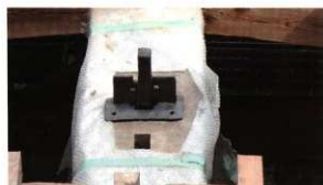
時鐘上部の吊り金物 (既存)
