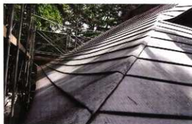
屋根隅棟部分
