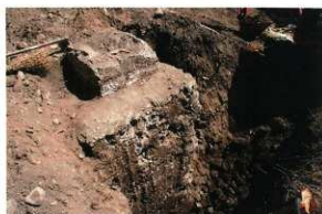
ラップコンクリート施工状況確認
