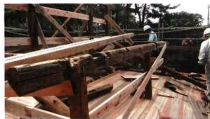
母屋の状況（転用材ホゾ穴が数か所あり）
