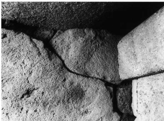
石櫛と西壁の構築状況 南東から
