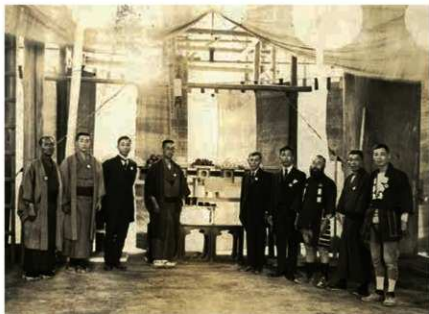
1 昭和4年(1929) 東大寺南大門修理工事上棟式 右から2人目、松太郎
