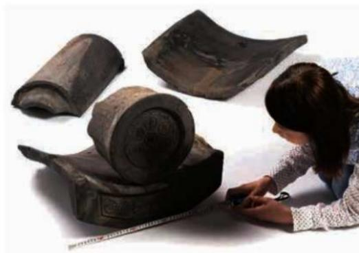
「東大寺大仏殿」銘の軒瓦一組は、字体などから元禄期の東大寺大仏殿の瓦とみられる。軒丸瓦瓦当径は約28cm、軒平瓦当幅は約48cm、丸瓦は幅約26cmで長さ約52cm、平瓦は幅約46cmで長さ約52cmと世界最大の木造建築物にふさわしい巨大な瓦である。
