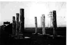
完成 (SB125, 柱表示, 8年度施工)
