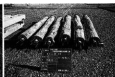
加工材搬入 (柱頭部)
