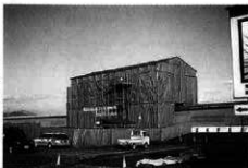
養生用小屋組
