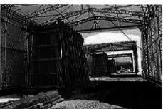
覆屋テント・仮枠設置完了
