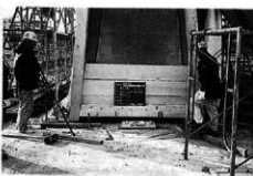
貝形壁板・地覆取付
