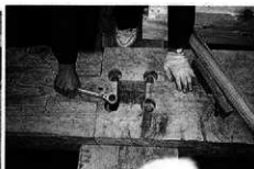
柱頭部補強ボルト締め
