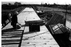
屋根板葺き込み状況
