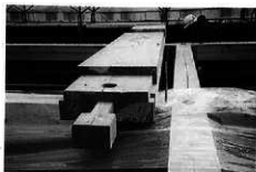
桁行台輪仕口
