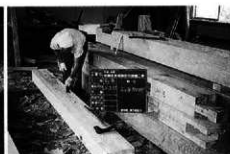
台輪加工 (ヨキ仕上げケバ落し)
