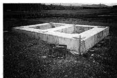
基礎完成 (地中梁)
