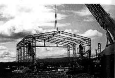
仮設工事：覆屋テント組立
