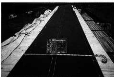
防水シート施工（2層目）
