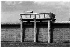
完成 (SB121, 8年度施工)
