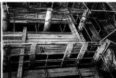
間柱連方・間渡し取付け
