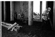
土工事：三和土敷込み
