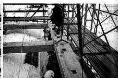
桁行台輪継手納め
