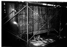
紅工事：木骨組縄掛付
