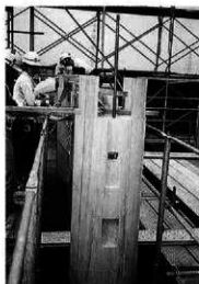
丸柱補強ボルト取付け
