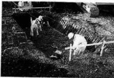
基礎工事：レベリング砂敷均し転圧
