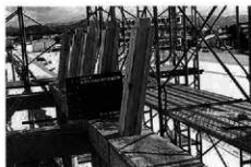
壁束取付完了
