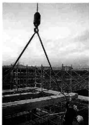
梁行台輪組上げ
