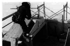
矢倉置横板取付
