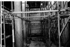
板壁取付完了
