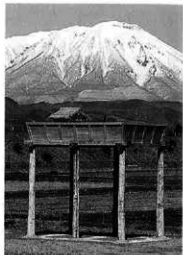
完成 (SB115, 5年度施工)
