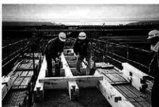
木工事：軸組組立
