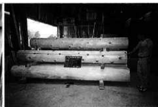
丸柱加工寸法確認
