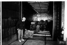
防腐加工工事：木材人工乾燥
