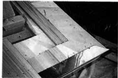
屋根工事：軒銅板水切取付け
