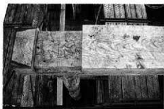
梁行台輪と柱頭部取合 (ステンレスボルトで補強)
