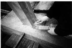
壁束脚部シール作業
