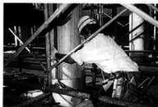
丸柱据付作業
