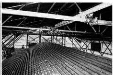
野地木舞取付け
