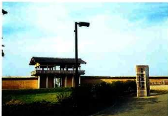
入口広場照明灯 1
