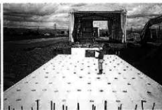
E P S設置完了
