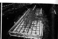
鉄筋・型枠組立て
