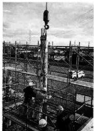
木工事：柱建て
