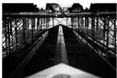
棟木取付け (母屋)
