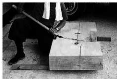
木工事：唐居敷加工（楯鉾仕上げ）
