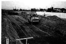
基礎工事：レベリング砂敷均し転圧
