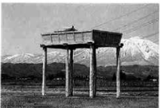
完成 (SB124, 7年度施工)
