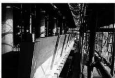
2階縦壁取付け
