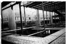
2階壁板取付け
