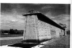
完成 (6年度施工, 1・35~42スパン)
