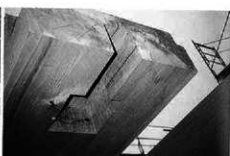
桁行台輪仕口
