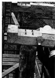
梁行台輪と柱頭部納め (隙間にエポキシ樹脂注入)
