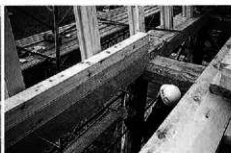
壁束固定用埋込みボルト入れ
