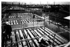
木工事：2階壁板取付け
