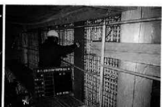
荒壁塗 (縄隠し)
