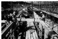
頭貫取付作業
