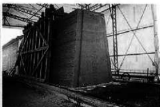
版築完了・仮枠移動
