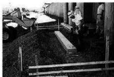
木階段取付け
