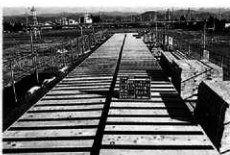
屋根板葺き込み・防水テープ施工
