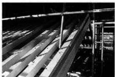
破風板取付け
