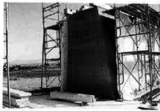
木工事：貝形（外郭南門側）柱建込
