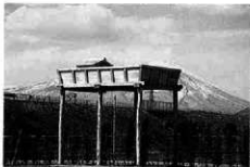
完成 (SB114, 6年度施工)
