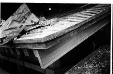
葺き軒先詳細・破風板
