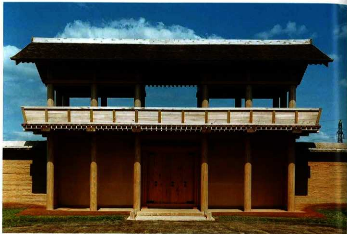
外郭南門正面（南から）
