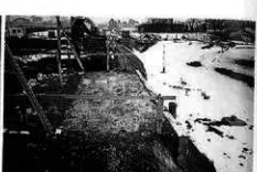
土留め不透水盛土工
