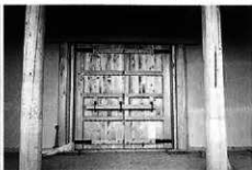
扉取付け（背面，門）
