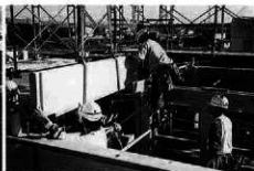
板壁取付作業
