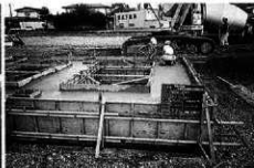
コンクリート打設
