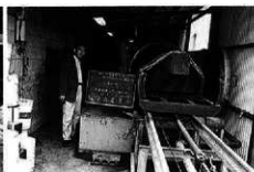
防虫防蟻材剤注入
