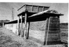
完成 (5年度施工, 2~13スパン)
