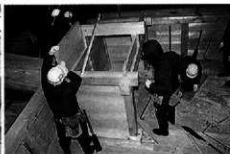
矢倉組立作業
