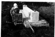
コンクリート出来方
