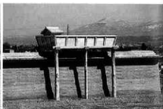
完成 (SB117, 5年度施工)
