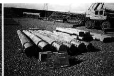
加工材搬入 (柱脚部、ステンレス根柢)
