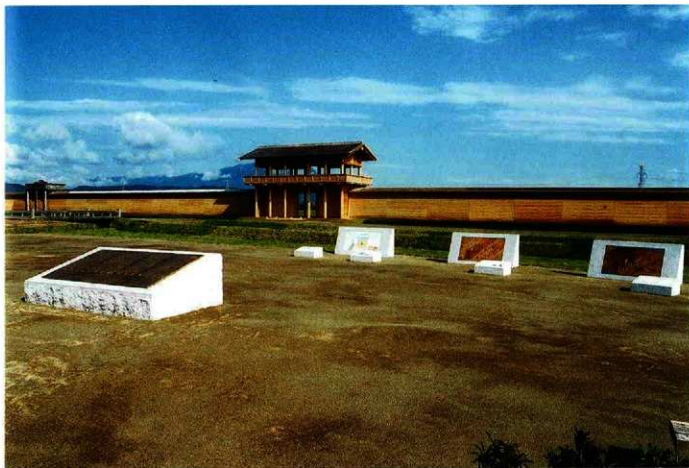
第I期整備地（入口広場から）
