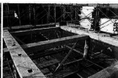
台輪組立完了
