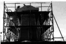
貝形・破風板取付
