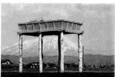
完成 (SB126, 8年度施工)
