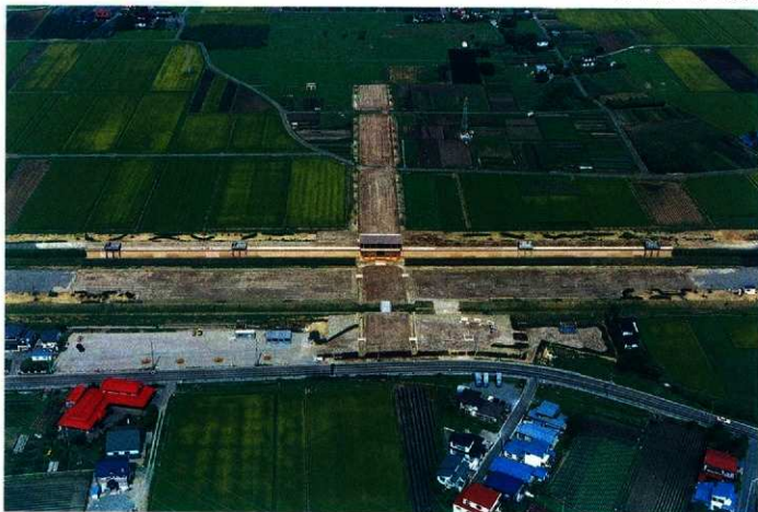
第I期整備地全景(南上空から)
