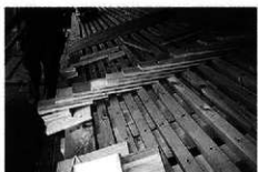
屋根工事：榑葺
