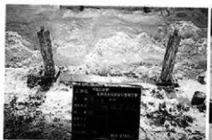
木工事：柱建方
