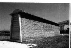
完成 (7年度施工, 22~24・30~34スパン)
