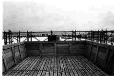
木工事：腰壁組立完了
