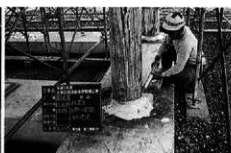
柱脚部モルタル充填・エポキシ樹脂注入
