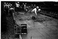
コンクリート打設
