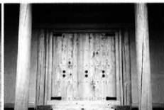
扉取付け（正面）
