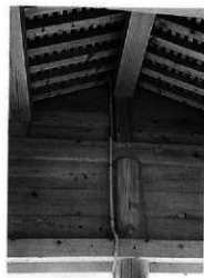
配管取付け (2階内部)
