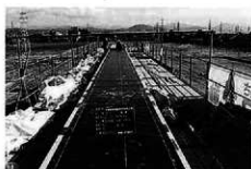
防水シート施工（1層目）
