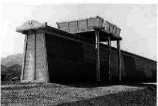
完成 (SB122, 6年度施工)
