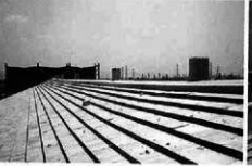
木工事：降泥板取付け
