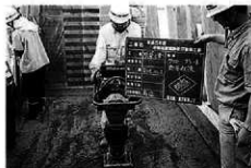
版築工事：ランマー転圧
