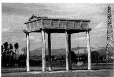
完成 (SB123, 6年度施工)
