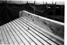
避雷設備工事：導体取付け
