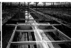
頭貫・梁行台輪取付け
