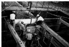
板壁取付作業
