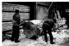
木工事：製材準備
