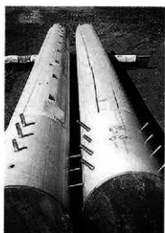
丸柱脚部ステンレス根捲き
