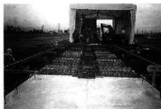
鉄筋・型枠組立て
