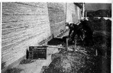
養生盛土工事：排水シート敷設・盛土
