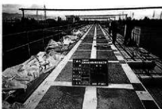
軸組組立・版築完了
