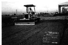
基礎工事：レベリング砂敷均し転圧
