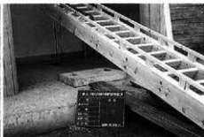
木工事：梯子組立て，梯子盤
