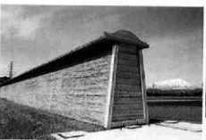
完成 (7年度施工, 14~21スパン)
