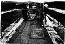
上土工事：下地材転圧
