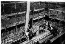
木工事：丸柱建方作業
