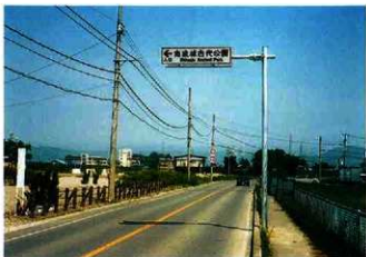
道路案内標識
