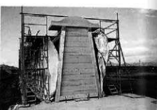
貝形・破風板取付完了
