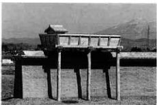
完成 (SB116, 5年度施工)
