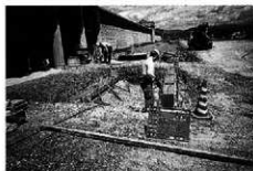
橋設置工事：基礎コンクリート打設
