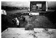
基礎工事：レベリング砂敷均し転圧
