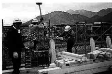
木工事：壁束取付作業
