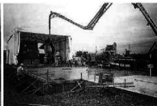
コンクリート打設
