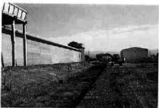
土工事：築地線・溝整形
