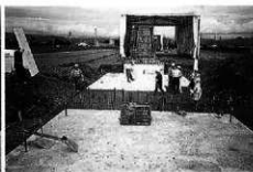
E P S設置作業
