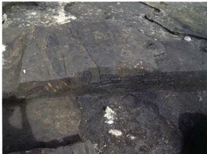
外郭西辺 (第104次) 地版築(右)と崩壊した版築塊(左)
