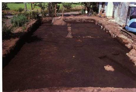
郭内北東部（第101次） 調査区全景（南から）
