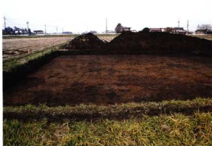
4 東区 [太田線 No.4 鉄塔変更] 西半部全景 (南から) ※遺構検出なし、鉄塔新設箇所
