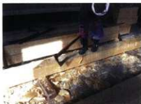
外郭南門の木橋解体修理 2
