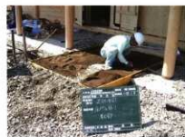
建物外周タイル敷き
