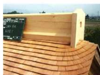
上棟木・鬼板取付
