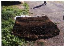
剥ぎ取り完了
