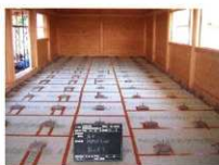
床下断熱材敷込み
