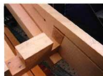
飛檐垂木・茅負・破風の取り付き
