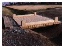
外郭南門の木橋解体修理 9
