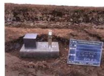
コンセントボール設置
