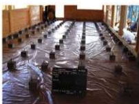
床下防湿シート敷込み
