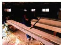
アリガンテ 槍鉋による加工
