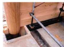
妻側の本柱・地覆・板壁施工
