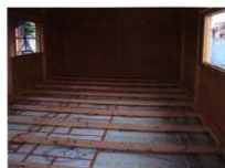
床下配線・配管、根太取付
