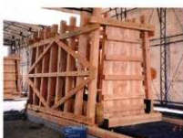
版築型枠設置
