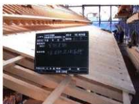
下屋根根流し板取付
