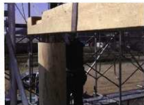
外郭南辺の槽解体修理 6
