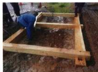
外郭南門の木橋解体修理 6
