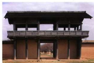
外郭南門の土壁
