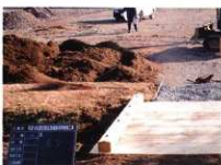
完成 (南大路木橋)
