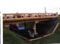
外大溝の木橋解体修理 6
