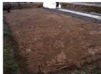
基礎碎石・敷砂敷き均し
