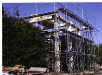
外郭南辺の槽解体修理 5
