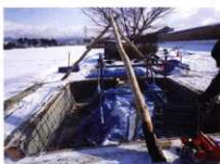
擁壁モルタル造形鉄筋
