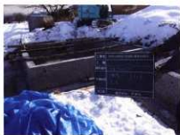
擁壁コンクリート打設
