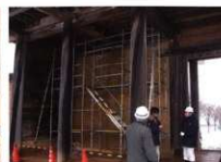
外郭南門の土壁復旧 6
