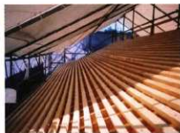
野木舞の施工
