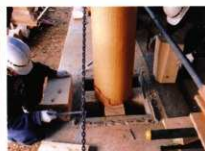
本柱の木楔による根固め
