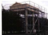
外郭南辺の槽解体修理 9
