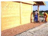
建物外周砂利敷き 2
