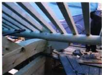
組み物の施工
