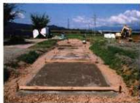
レベリング砂敷き均し
