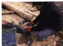
擬木固定アンカー設置
