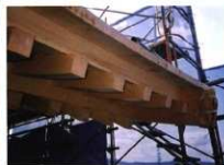
軒隅下の軒先構造
