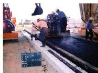
基礎開粒度アスファルト舗装
