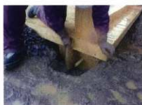
外郭南門の木橋解体修理 8
