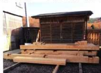
外郭南門の木橋解体修理 1
