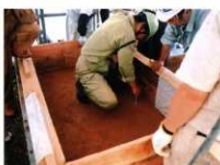
試験施工（突詰め状況確認）
