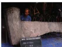
煙道モルタル造形
