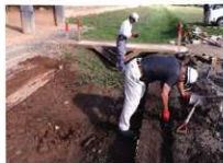
外郭南門の木橋解体修理 3
