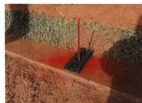
外郭南門の木橋解体修理 4
