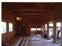
間仕切下地、開口枠組立
