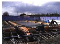
コンクリート打設
