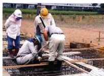
基礎コンクリート打設
