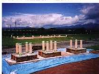
柱表示部基礎コンクリート打設
