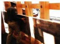
版築型枠堰板据付
