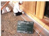
基礎立上り部仕上げ
