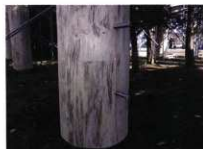
外郭南辺の槽解体修理 4
