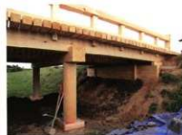
外大溝の木橋解体修理 5
