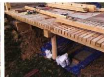
外大溝の木橋解体修理 3
