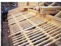
下屋部分垂木取付
