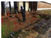
外郭南門の木橋解体修理 5
