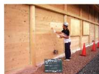
外壁防腐剤塗布
