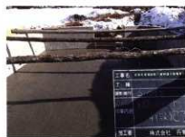
土間コンクリート打設
