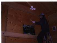
内壁防腐剤塗布
