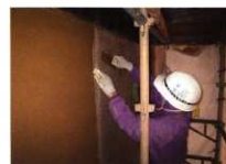
外郭南門の土壁復旧 4
