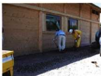
建物外周砂利敷き 1
