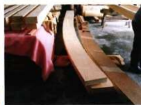
破風板の加工
