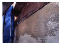
外郭南門の土壁復旧 1
