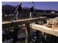
外郭南辺の槽解体修理 7
