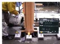
柱脚部無収縮モルタル充填
