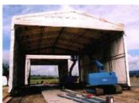
覆屋テント設置
