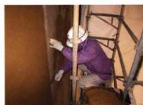
外郭南門の土壁復旧 5
