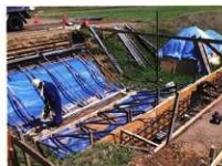
外大溝の木橋解体修理 2
