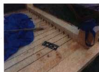
外郭南門の木橋解体修理 7
