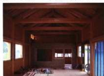
間仕切壁石膏ボード張り・塗装
