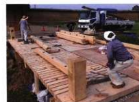
外大溝の木橋解体修理 4
