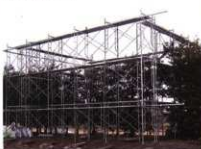
外郭南辺の槽解体修理 2
