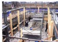
柱建方、地覆・壁板嵌込み
