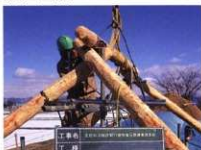
擬木組立・溶接
