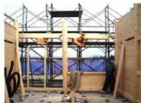
窓敷居・鴨居廻り施工
