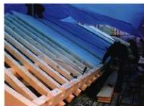
野地板の施工
