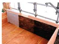
試験施工（堰板クリ材の版築）
