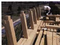
外郭南辺の槽解体修理 8
