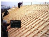
母屋・野垂木取付
