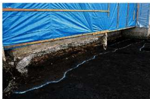
SB236掘立柱建物跡（北東から）
