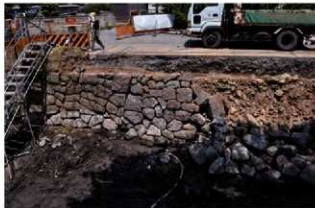
写真左側の2mほどを余分に解体して積み直した
