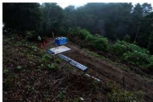
南二の曲輪 バイオトイレ基礎設置 (主郭より)
