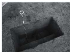
D. HP01PH03 (断面調査:南西より)
