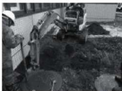
H. 大学院高棟屋外排水管修理工事(東より) 1613
