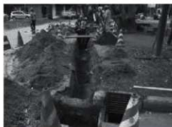
G. 中央道路雨水橋設置工事(東より) 1611
