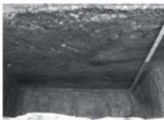
B. 獣医学研究科支障配管切り直し(排水管等)工事 TP02 西壁 1605
