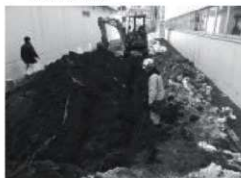
C. 屋外運動場消火設備修理工事(西より) 1601
