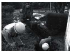
E. 工学部噴水設備給水管取替工事(北より) 1609
