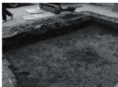
D. 総合博物館・リアフリー工事(北西より) 1606
